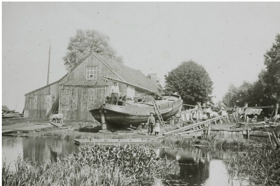
Afb.5.19 Scheepshelling van Langweer. Let ook op de zware staanders rechtsachter waaraan tevens de waslijn is bevestigd.
