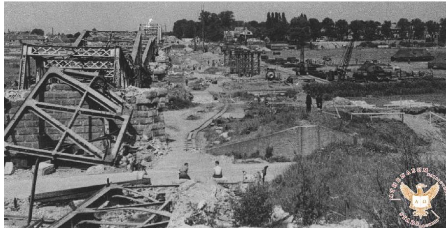
Afb. 4.12 De bouw van de noodbrug door de Royal Engineers na de Tweede Wereldoorlog (bron: Deventer in Beeld).
