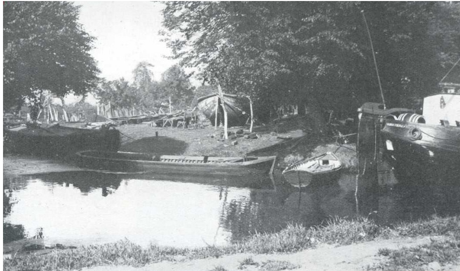
Afb.5.18 Scheepswerf van Veendam. Bovenop de helling zijn diverse staanders geplaatst ter ondersteuning van de schepen.
